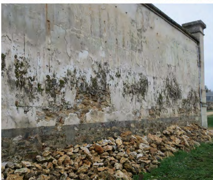
Des murs s'effondrent, notamment à cause d'infiltrations d'eau. Le crépi doit aussi être refait.
